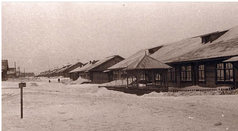
Застройка "Золотой горки". 1941
